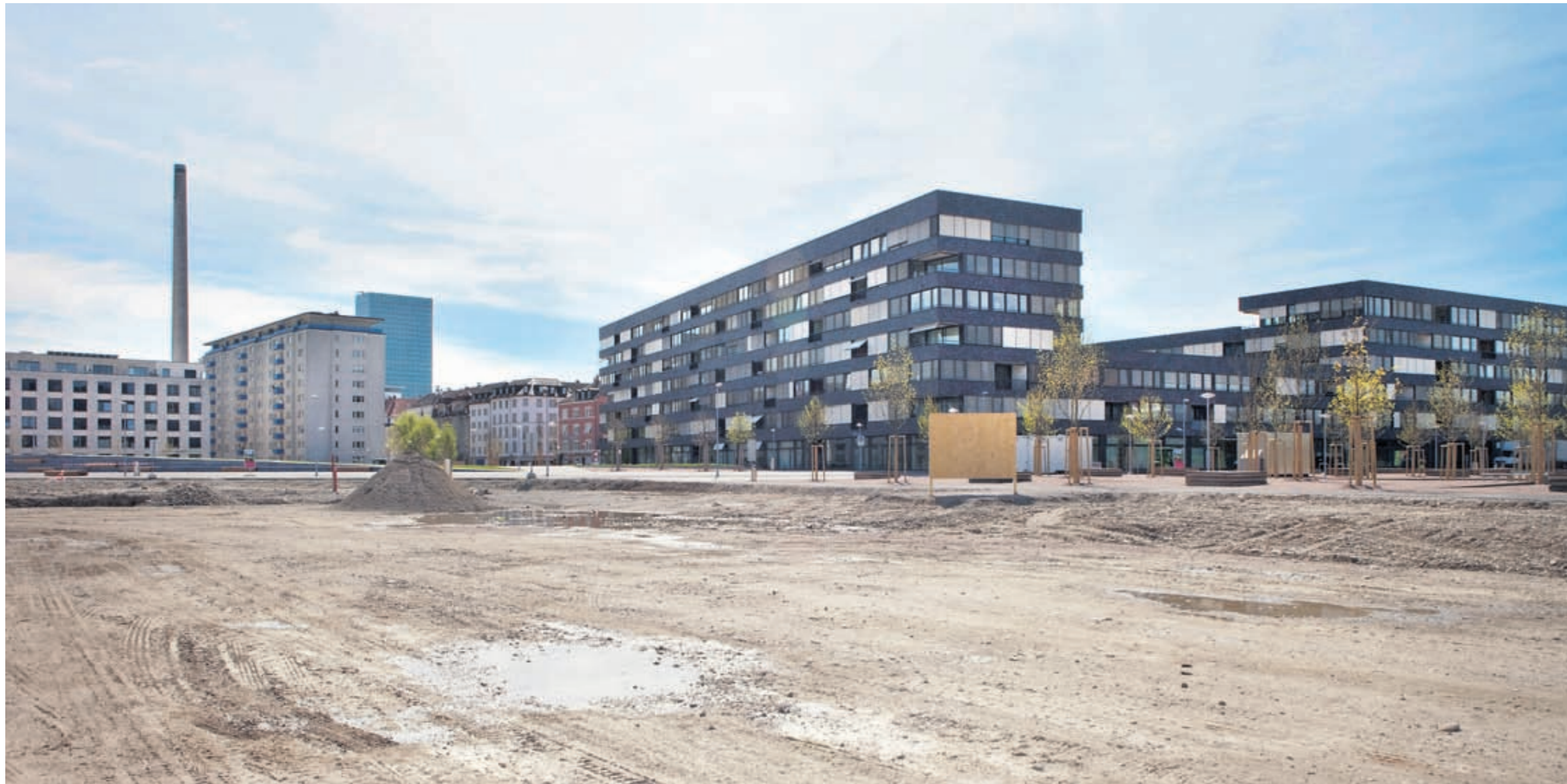
Die Erlenmatt. Rechts im Bild die Wohnüberbauung Erlenort; links ein Baufeld der Stiftung Habitat, auf dem schon bald Klee und Blumen spriessen sollen. Foto Mischa Christen
